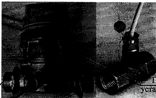
Рисунок 1 – Схема пломбировки счетчиков
