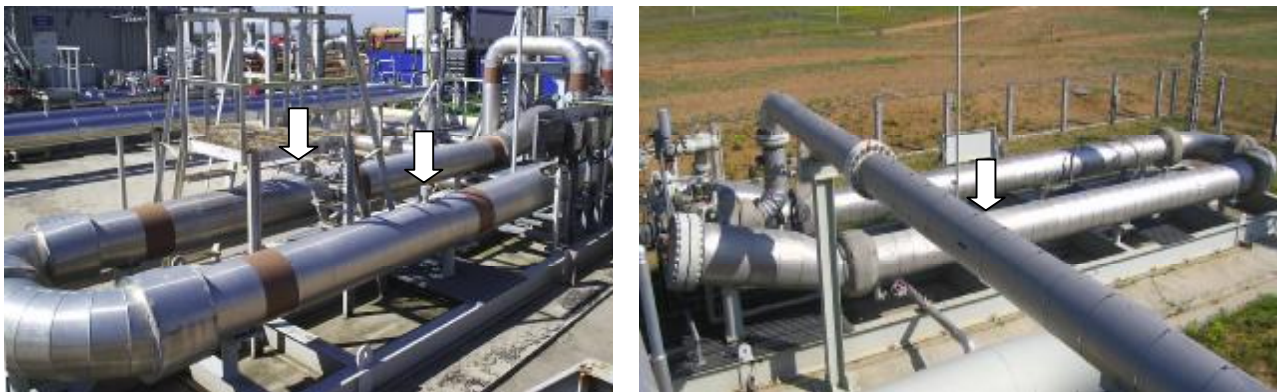
Рисунок 1 Общий вид ТПУ с указанием мест пломбирования
