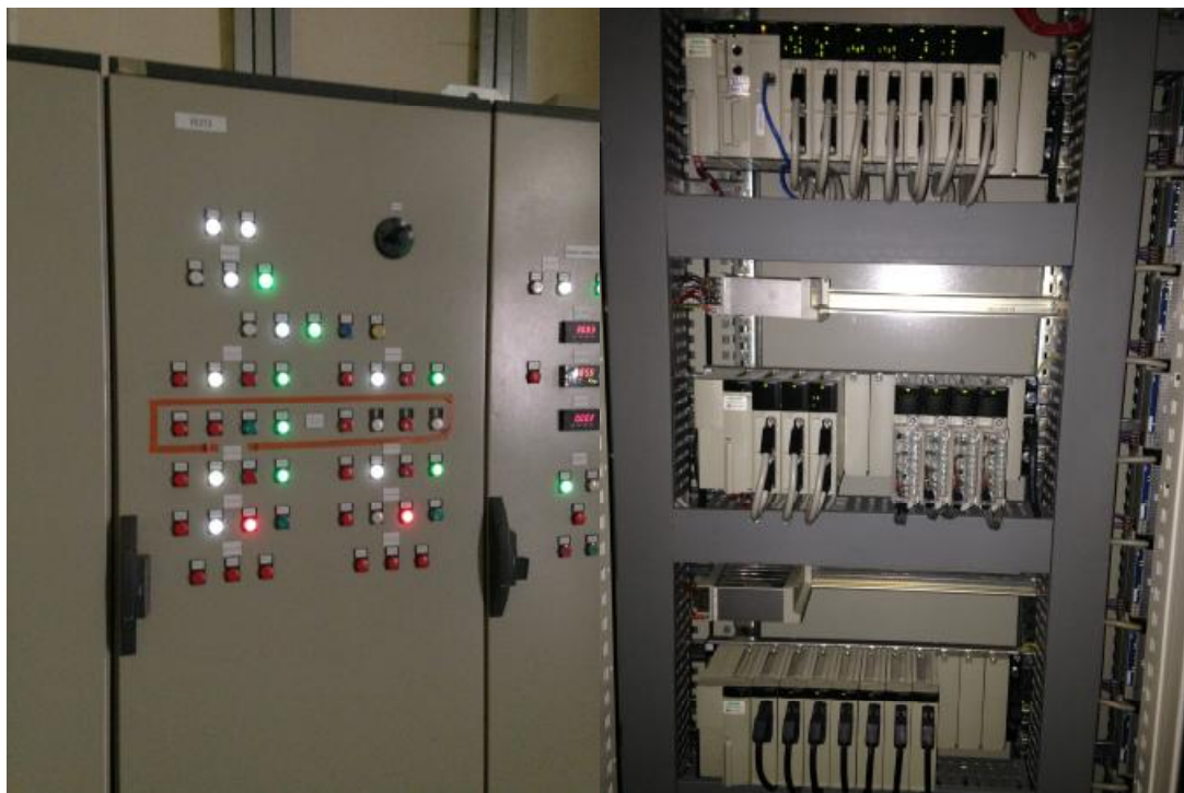
Рисунок 1 - Шкаф управления обработкой озона с контроллером PLC TSX Premium и модулями ввода
