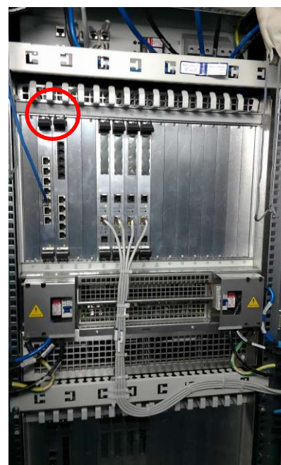
Рисунок 2 - Место блокирования кассетного модуля (выделено)
