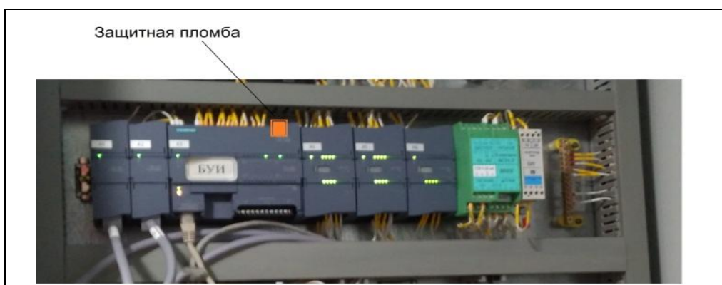
Рисунок 2 - Место пломбировки контроллера БУИ
