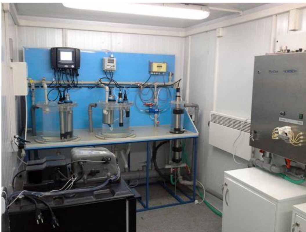
Рисунок 1 - Вид станции АСК-В в стационарном исполнении в отдельном модуле
