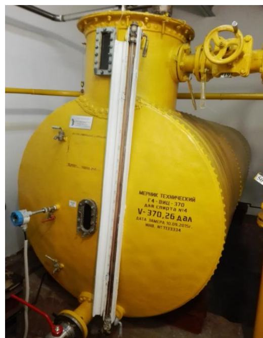
Рисунок 1 - Общий вид мерников Г4-ВИЦ-370, зав.№№ 5, 24
