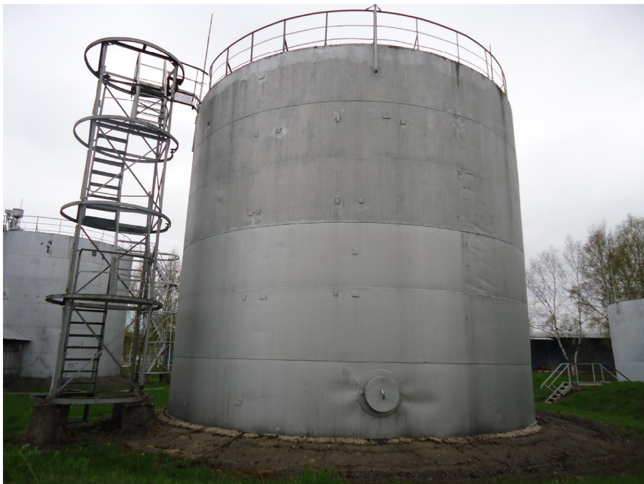
Фото 2 - Общий вид резервуара РВС-700
