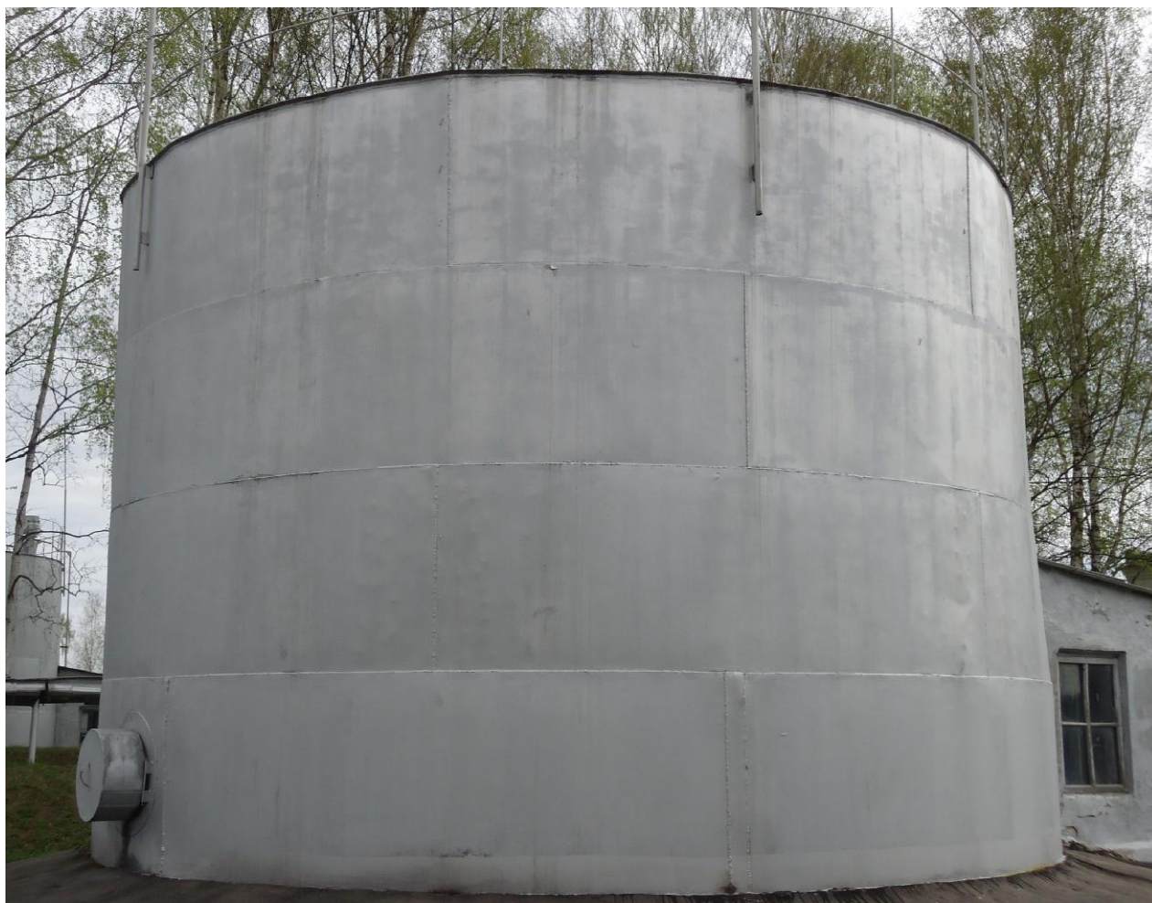
Фото 1 - Общий вид резервуара РВС-300
