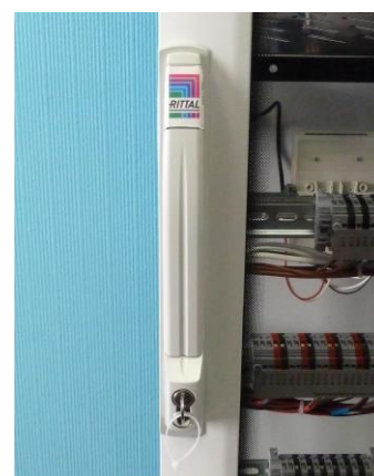
Рисунок 2 - Внешний вид замка на дверце электромонтажного шкафа
