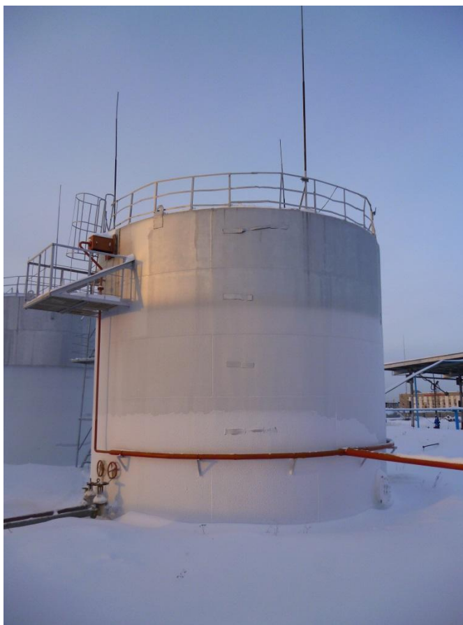
Рисунок 1 - Общий вид резервуара РВС-400
