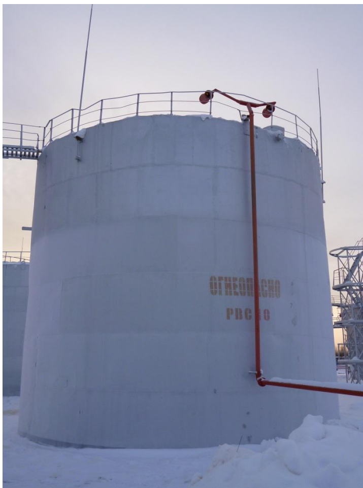
Рисунок 2 - Общий вид резервуара РВС-700
