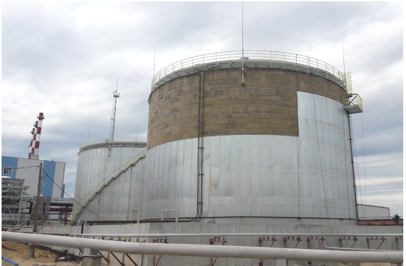
Рисунок 1 - Общий вид резервуаров
