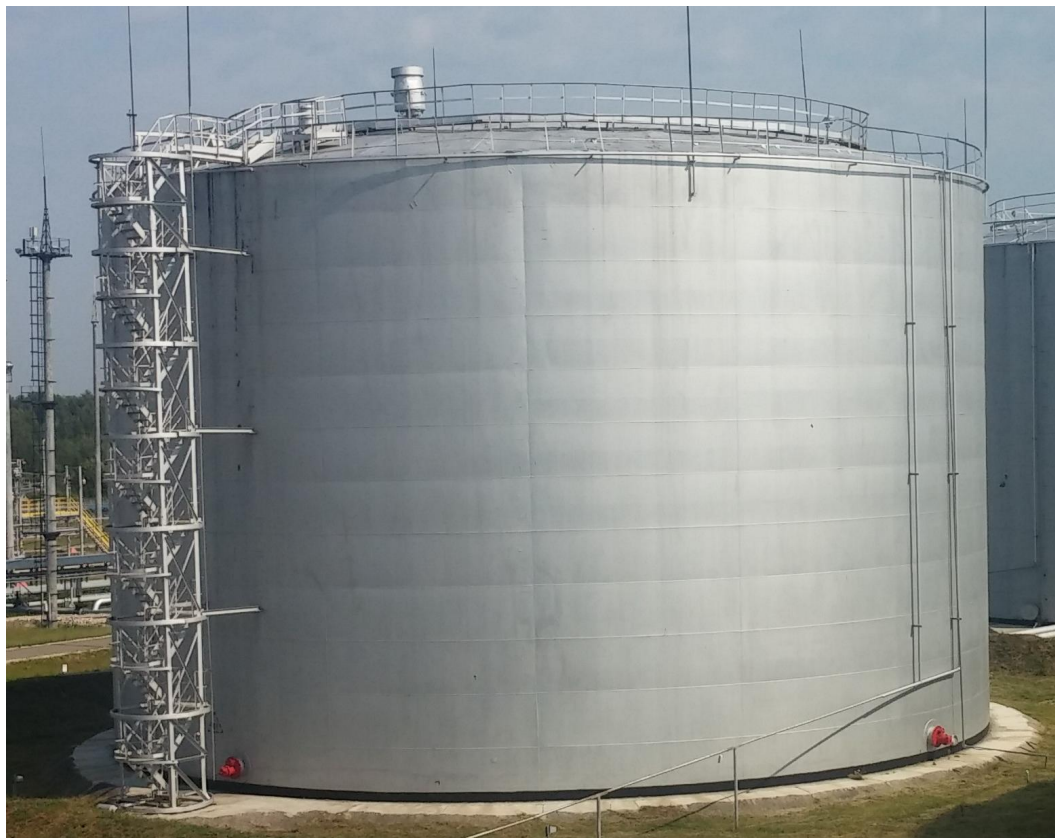
Рисунок 2 - Общий вид резервуаров вертикальных стальных цилиндрических РВС-10000
