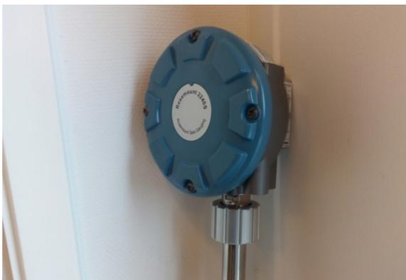
Рисунок 2 – преобразователь измерительный Rosemount 2240S
