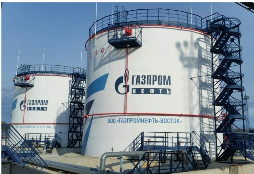
Рисунок 1 - Общий вид резервуара РВС-2000 заводские номера 1, 2
