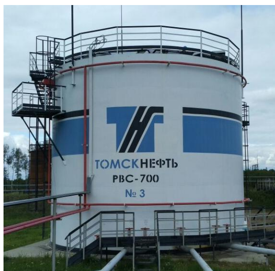
Рисунок 1 - Общий вид резервуара
