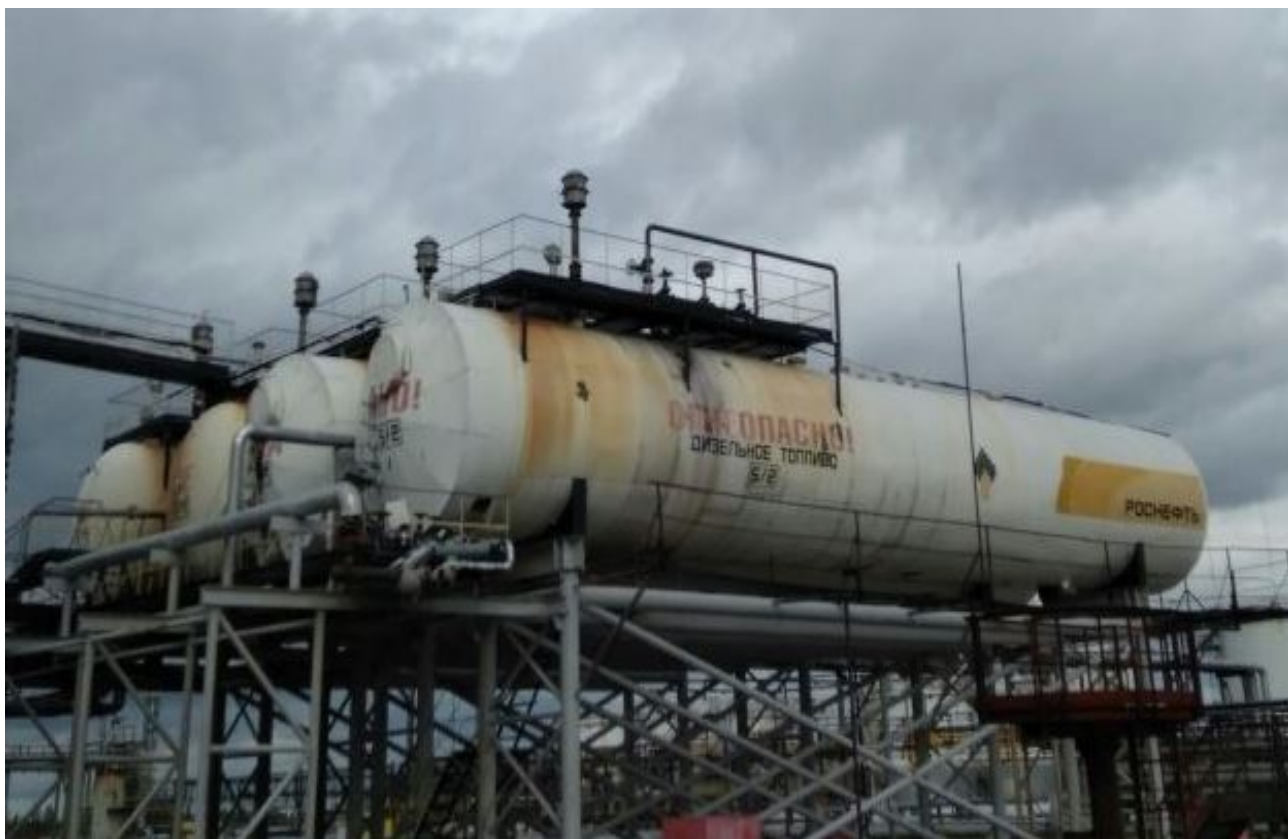
Рисунок 1 - Общий вид резервуара стального горизонтального цилиндрического РГС-200
