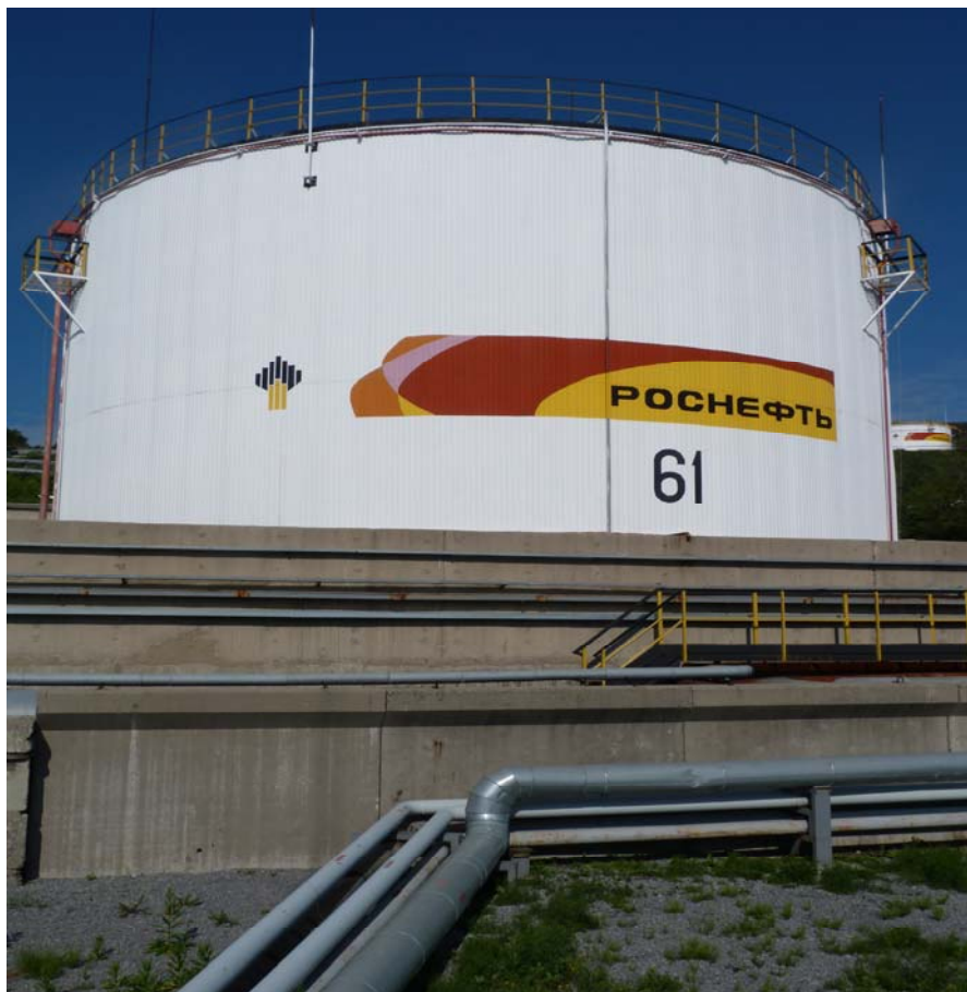
Рисунок 1 - Общий вид резервуара вертикального стального цилиндрического РВС-3000
