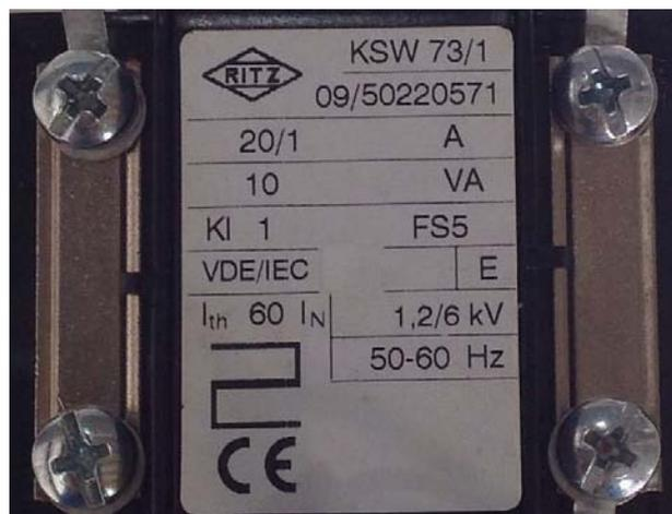
Рисунок 6 - Общий вид таблички технических данных трансформаторов тока KSW
