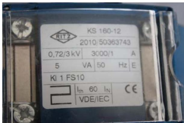
Рисунок 2 - Общий вид таблички технических данных трансформаторов тока KS
