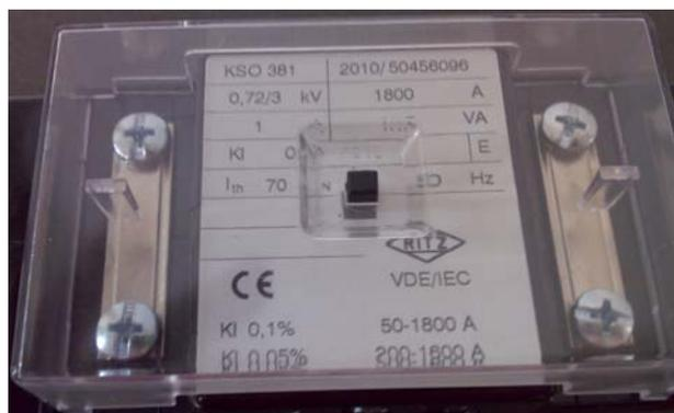
Рисунок 4 - Общий вид таблички технических данных трансформаторов тока KSO
