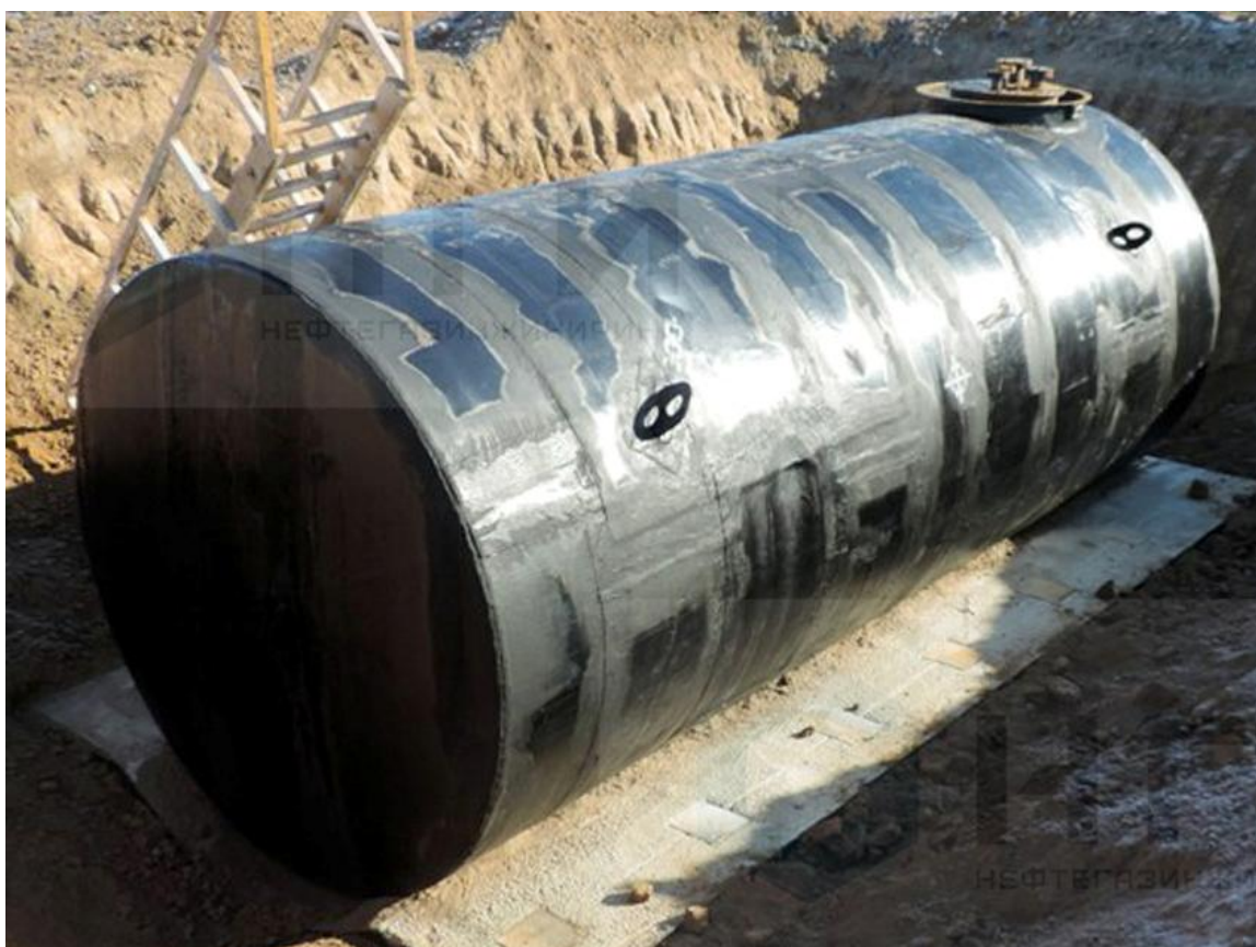
Рисунок 3 - Общий вид резервуара стального горизонтального цилиндрического РГС-70
