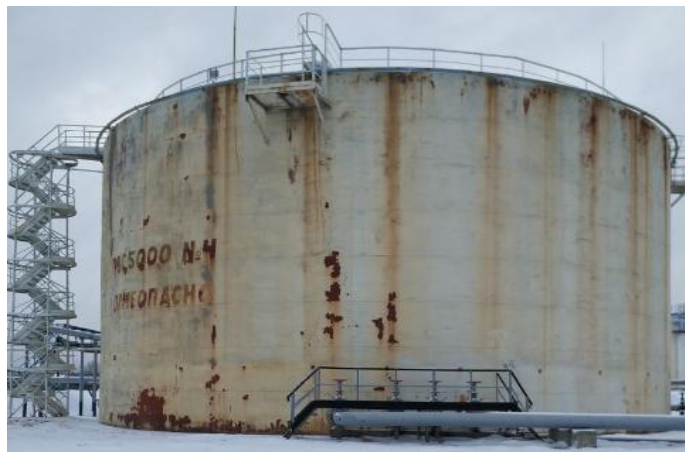
Рисунок 1 - Общий вид резервуара
