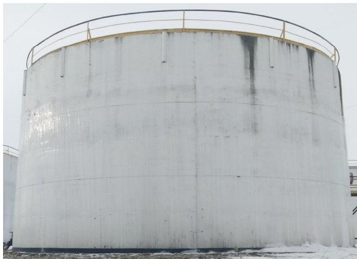
Рисунок 2 – Общий вид резервуара стального вертикального цилиндрического РВСП-1000
