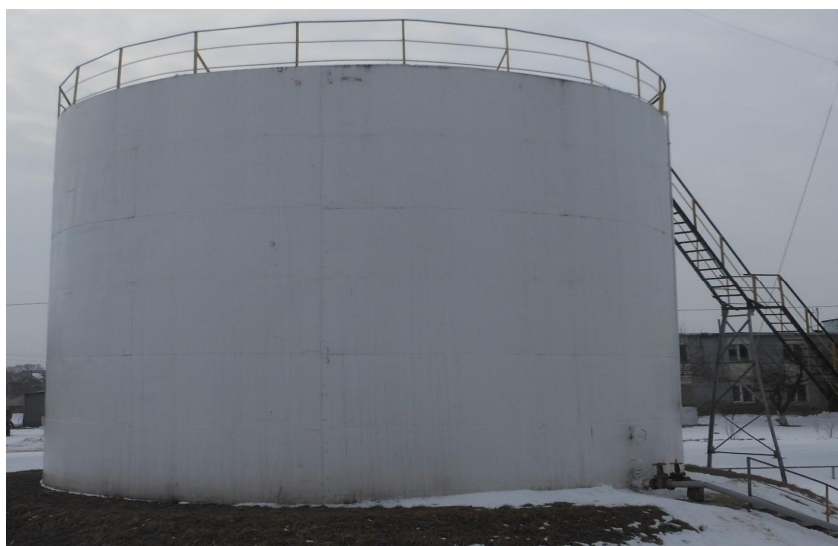
Рисунок 4 – Общий вид резервуара стального вертикального цилиндрического РВСП-700
