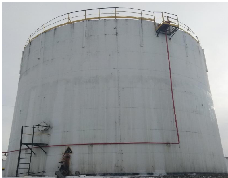
Рисунок 1 – Общий вид резервуара стального вертикального цилиндрического РВСП-2000
