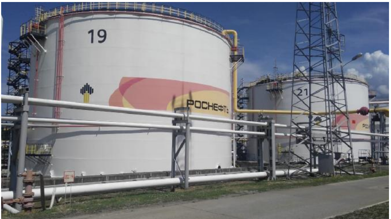
Рисунок 1 - Общий вид резервуаров
