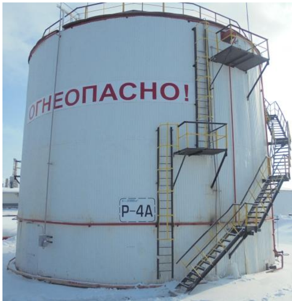
Рисунок 1 – Общий вид резервуара стального вертикального цилиндрического РВС-2000
