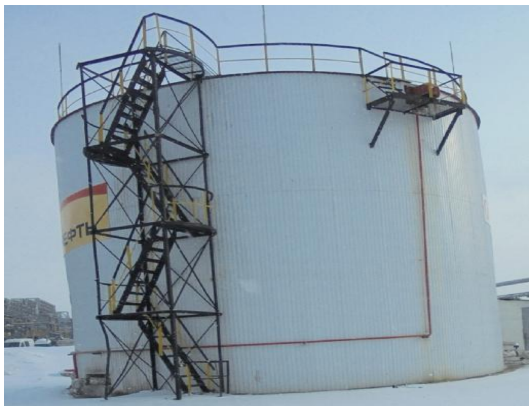
Рисунок 5 – Общий вид резервуара стального вертикального цилиндрического РВС-1000
