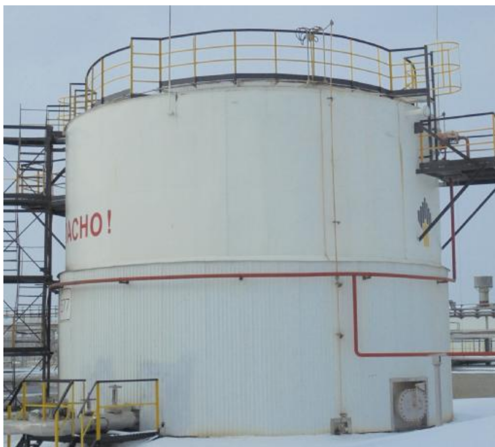
Рисунок 4 – Общий вид резервуара стального вертикального цилиндрического РВС-700
