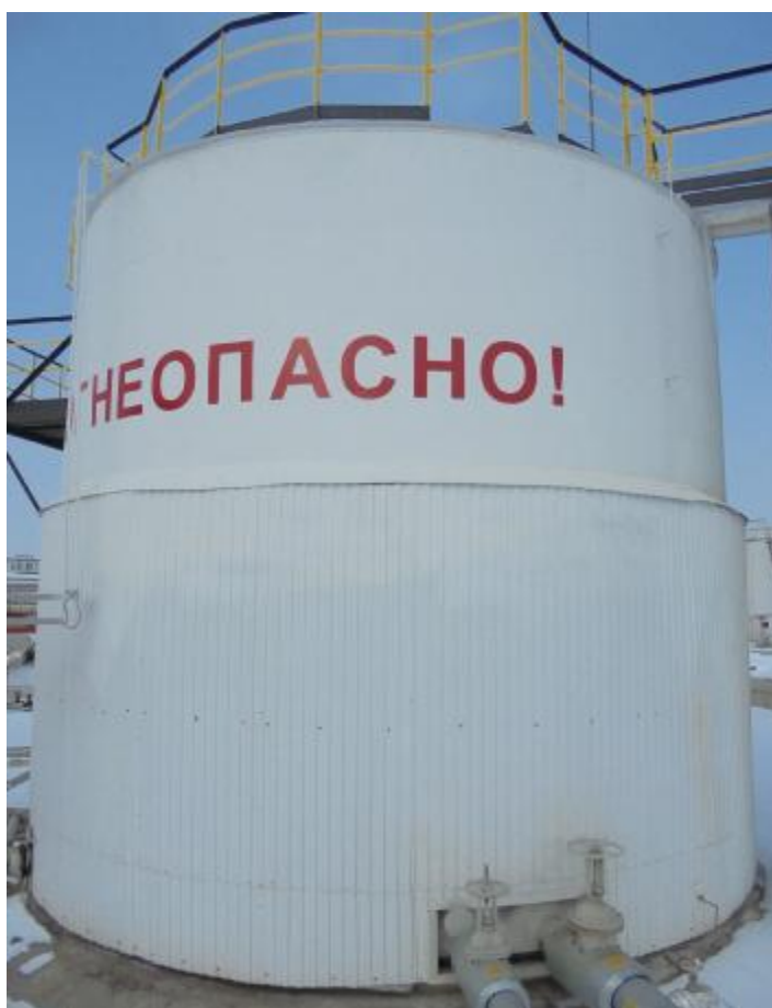
Рисунок 2 – Общий вид резервуара стального вертикального цилиндрического РВС-300
