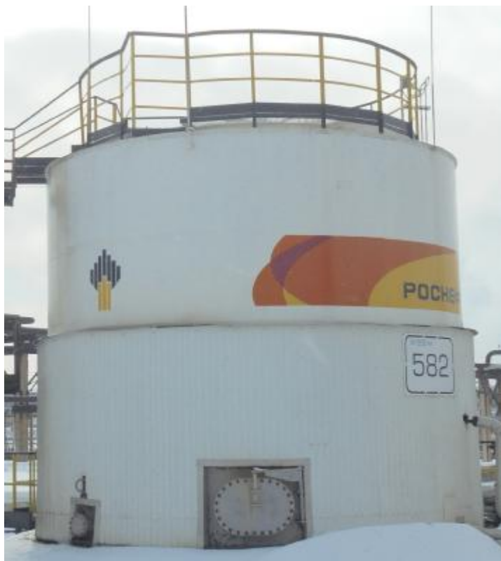
Рисунок 1 – Общий вид резервуара стального вертикального цилиндрического РВС-200
