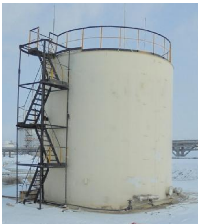
Рисунок 3 – Общий вид резервуара стального вертикального цилиндрического РВС-400
