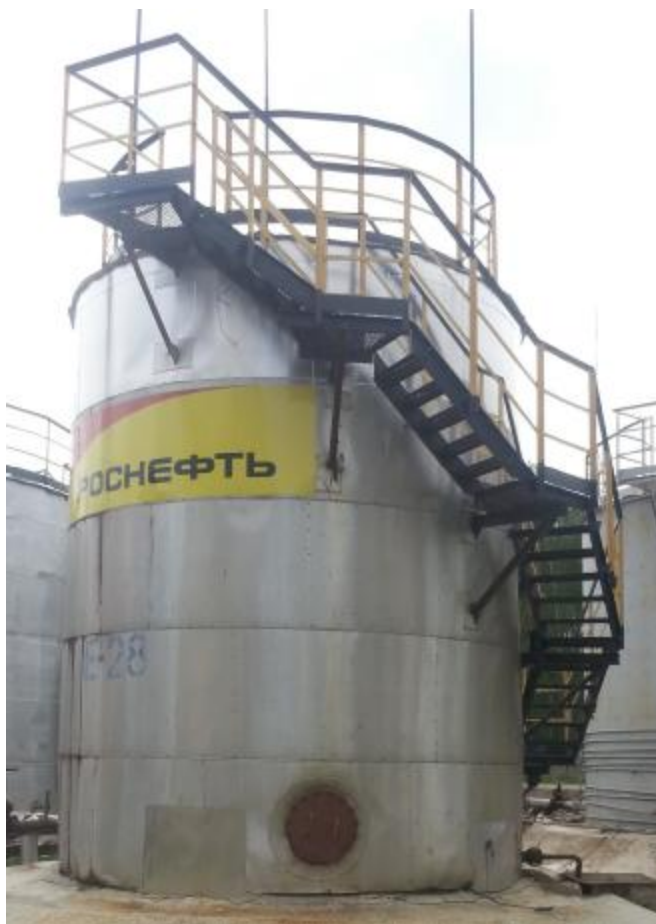
Рисунок 1 - Общий вид резервуара стального вертикального цилиндрического РВС-100
