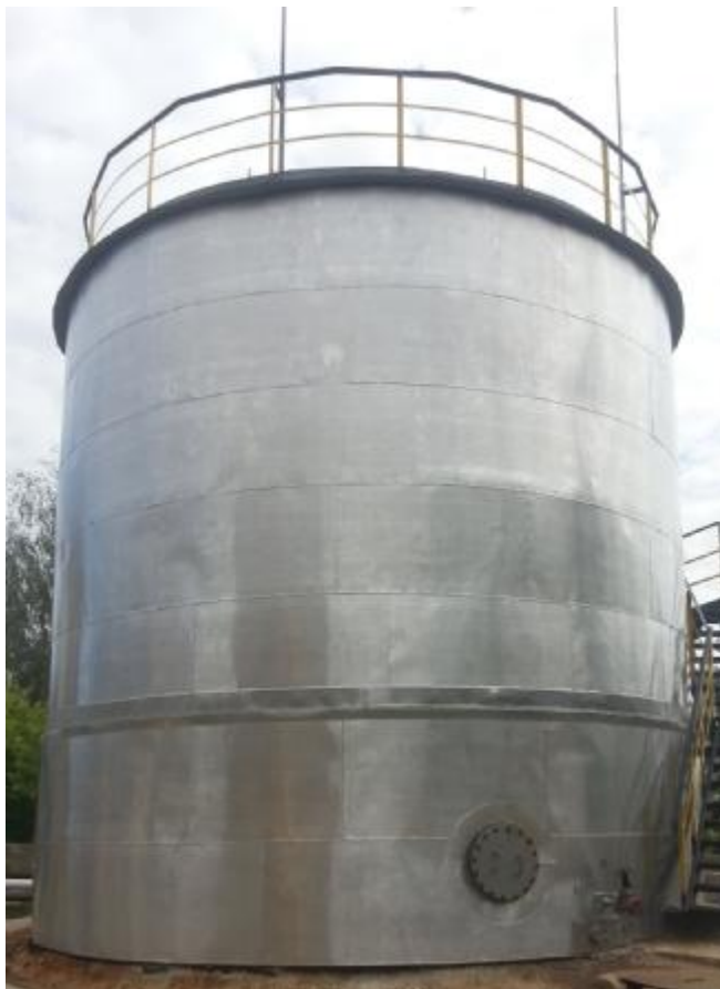
Рисунок 3 - Общий вид резервуара стального вертикального цилиндрического РВС-300
