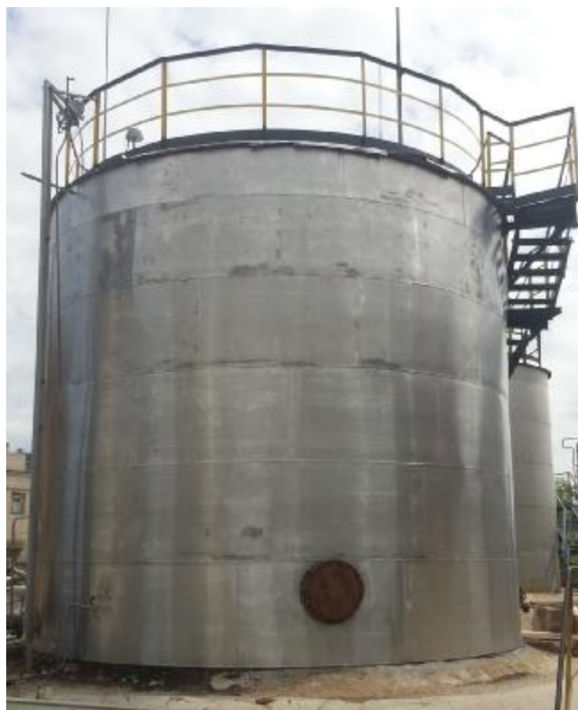
Рисунок 2 - Общий вид резервуара стального вертикального цилиндрического РВС-200
