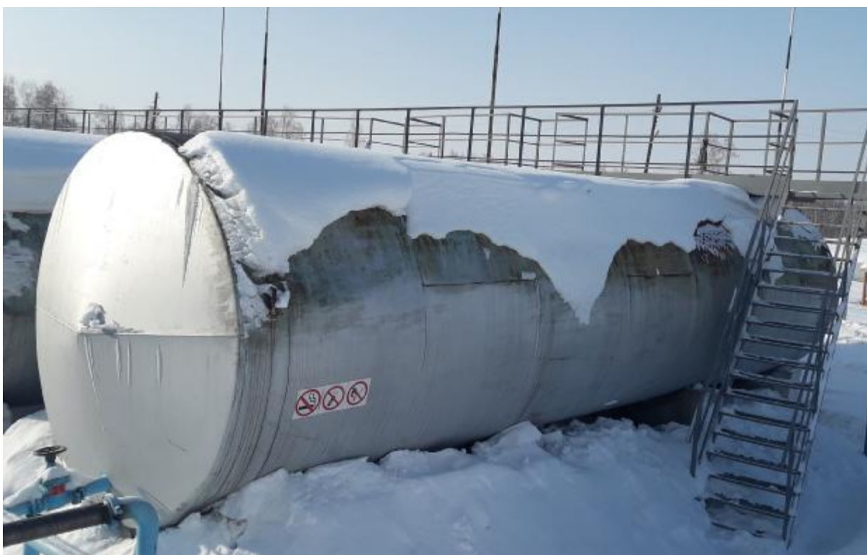
Рисунок 2 - Общий вид резервуара стального горизонтального цилиндрического РГС-60
