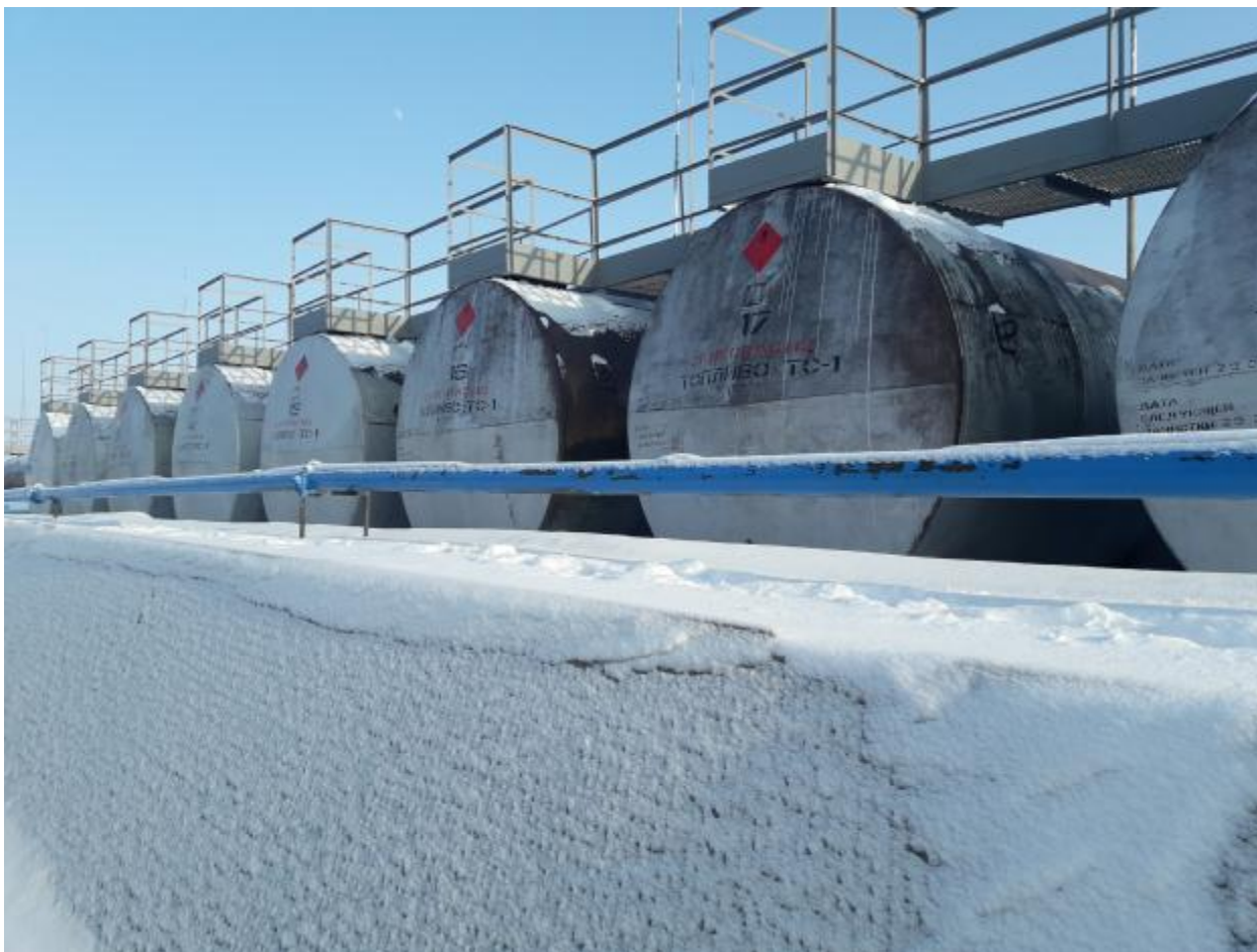
Рисунок 1 - Общий вид резервуара стального горизонтального цилиндрического РГС-50
