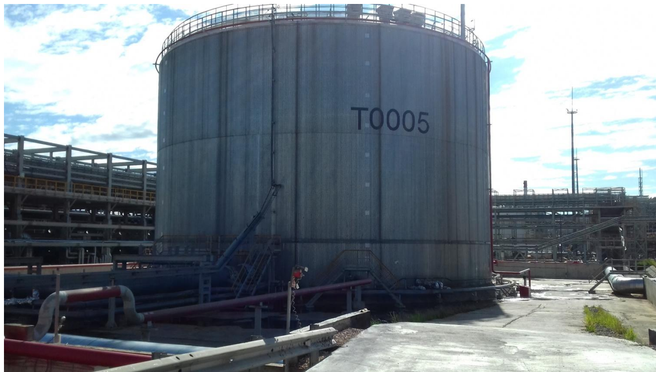
Рисунок 1 - Общий вид резервуара РВС-10000
