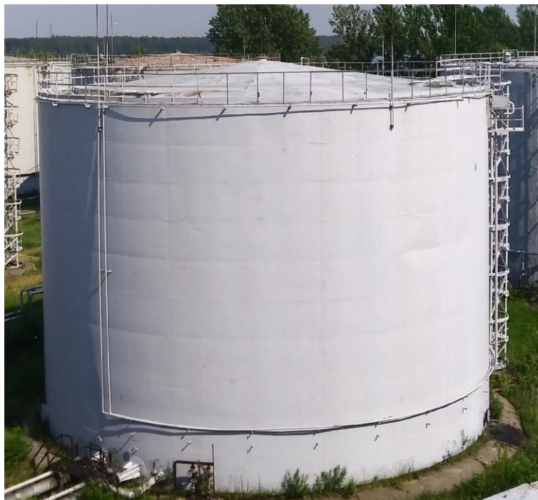
Рисунок 2 - Общий вид резервуаров вертикальных стальных цилиндрических РВС-5000, состоящих из 10 поясов
