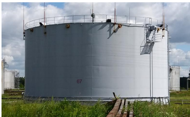
Рисунок 1 - Общий вид резервуаров вертикальных стальных цилиндрических РВС-5000, состоящих из 8 поясов
