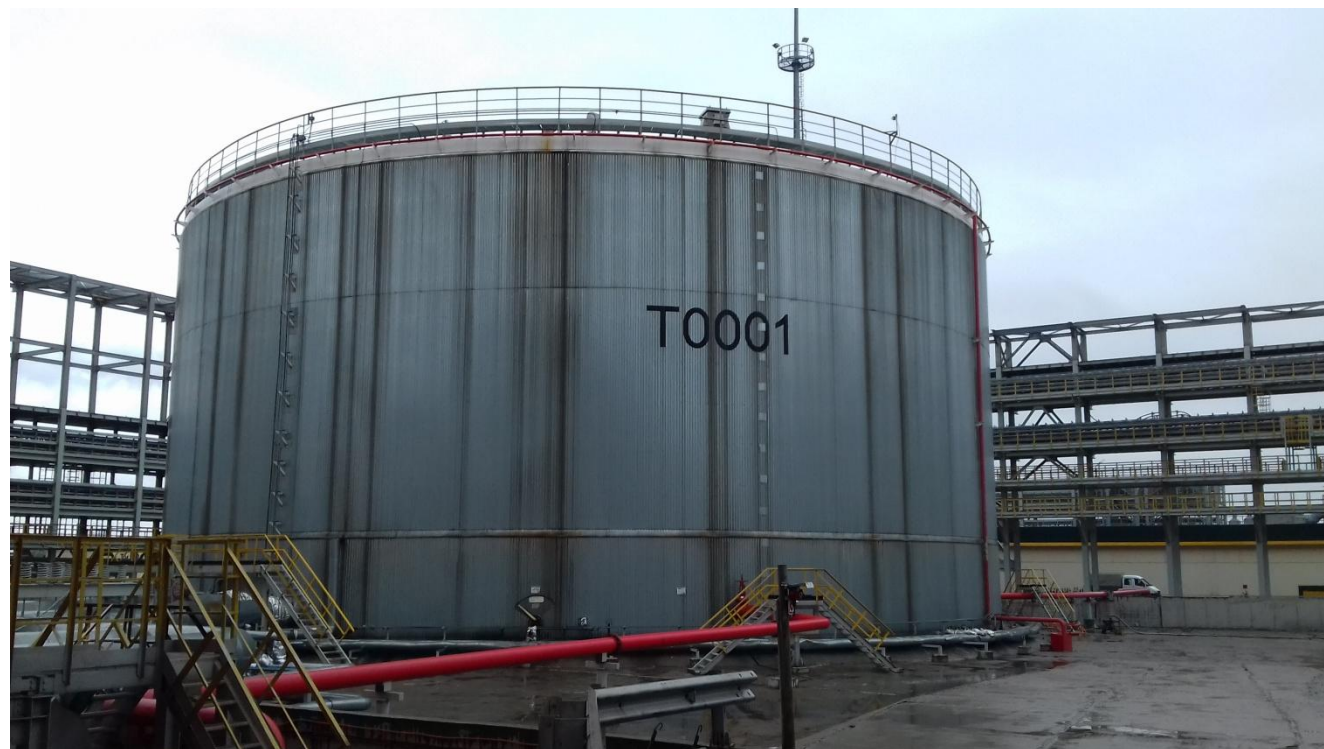
Рисунок 1 - Общий вид резервуара РВС-20000
