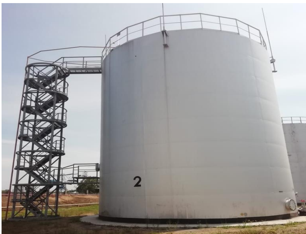
Рисунок 1 – Общий вид резервуара стального вертикального цилиндрического РВСП-1000
