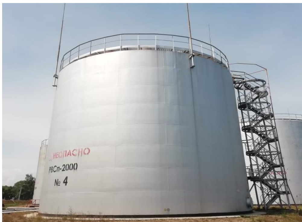
Рисунок 2 – Общий вид резервуара стального вертикального цилиндрического РВСП-2000
