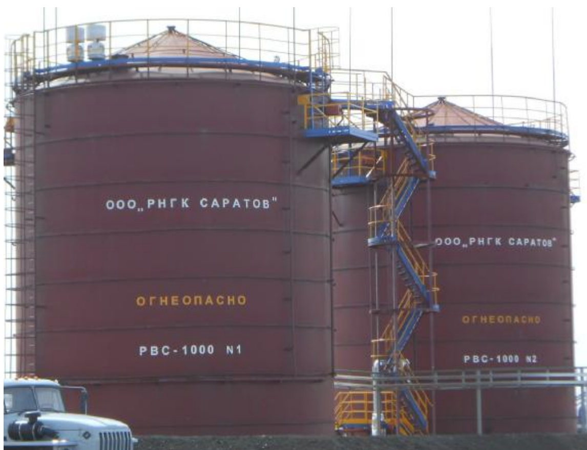
Рисунок 1 – Резервуар вертикальный стальной РВС-1000
