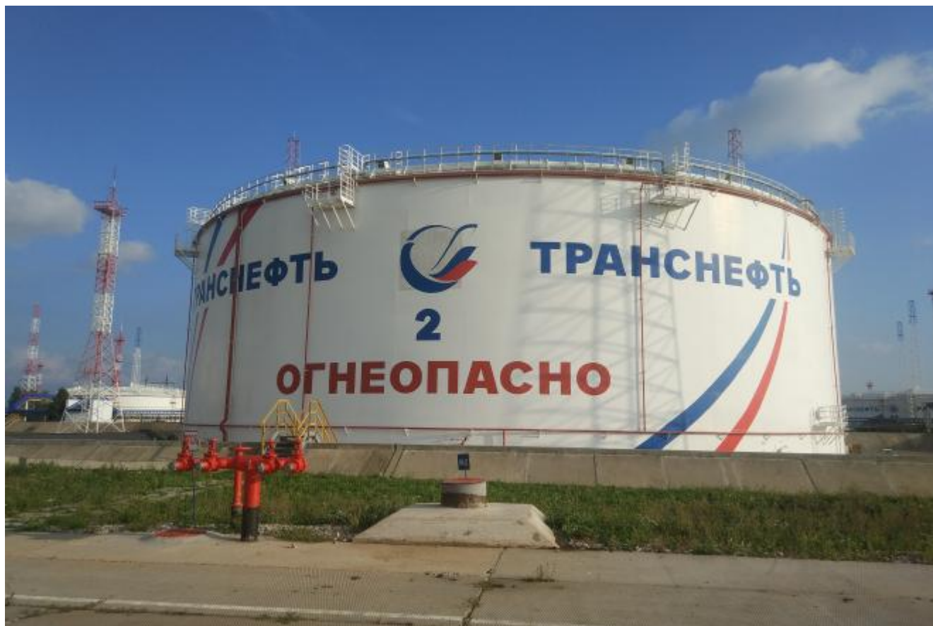
Рисунок 1 – Общий вид резервуара РВСП-50000
