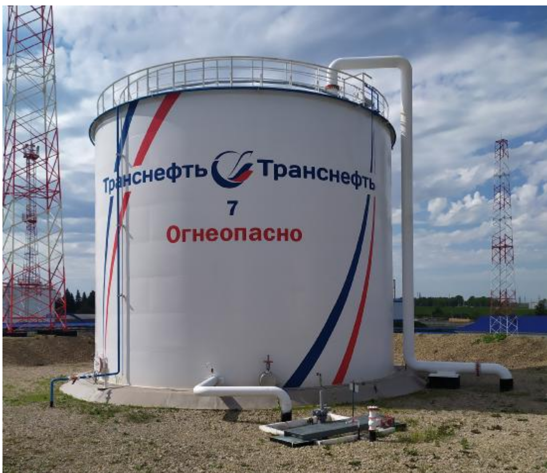
Рисунок 1 – Общий вид резервуара РВС-2000
