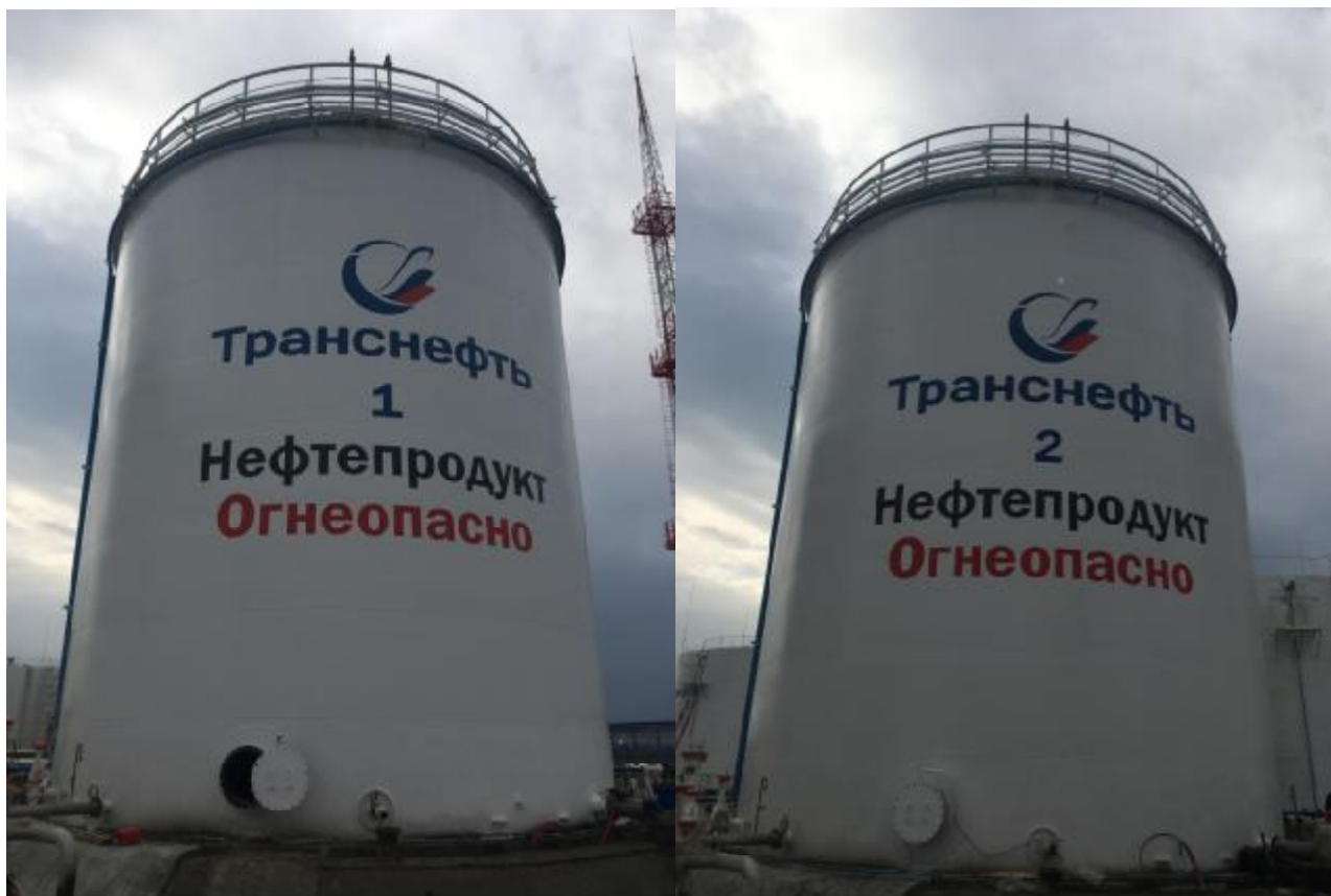
Рисунок 1 – Общий вид резервуаров стальных вертикальных цилиндрических РВС-1000
