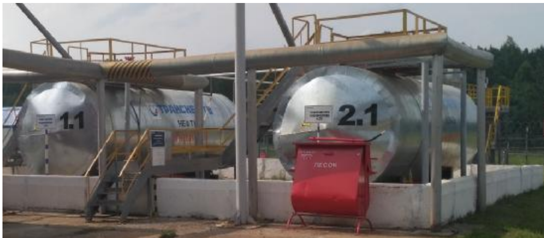
Рисунок 1 – Общий вид резервуаров РГС-20 (17+3) зав. №№ 6387 14/36, 6387 15/36
