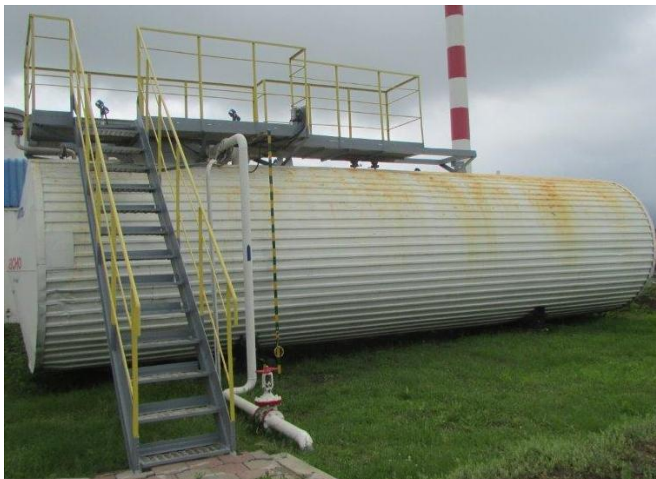
Рисунок 4 – Общий вид резервуара РГС-50 (45+5) зав. № 6432 7/8
