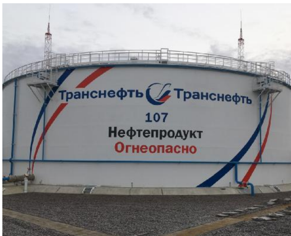
Рисунок 2 – Общий вид резервуаров стальных вертикальных цилиндрических РВС-20000 а) зав.№ 106, б) зав.№ 107
