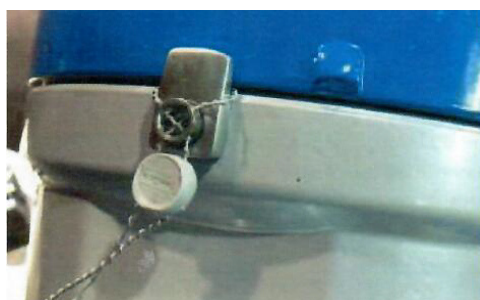
Рисунок 3 - Пломбирование корпуса счетчика
