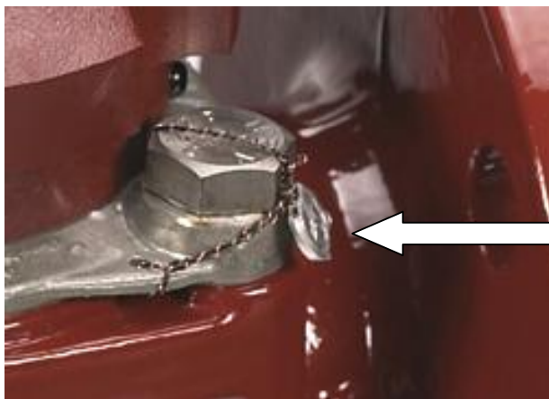
Рисунок 2 – Схема пломбировки от несанкционированного доступа, обозначение места нанесения знака поверки счетчиков холодной и горячей воды турбинных WP-Dynamic
