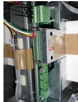
Рисунок 9- Место пломбирования блока питания ER5
