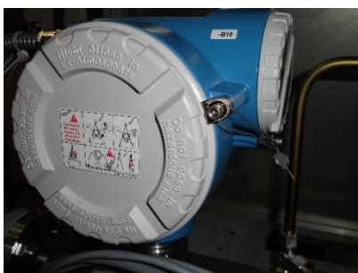
Рисунок 4- Место пломбирования расходомера массового
