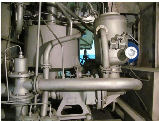
Рисунок 2 - Насосно-дозировочная установка
