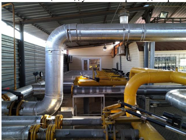
Рисунок 1 – Комплект эталонных критических сопел и запорно-регулирующей арматуры
