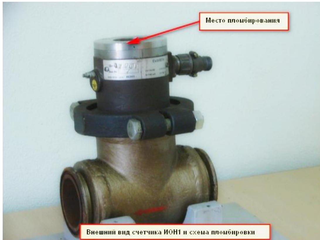
Рисунок 1 - ИОН1 и место пломбирования
