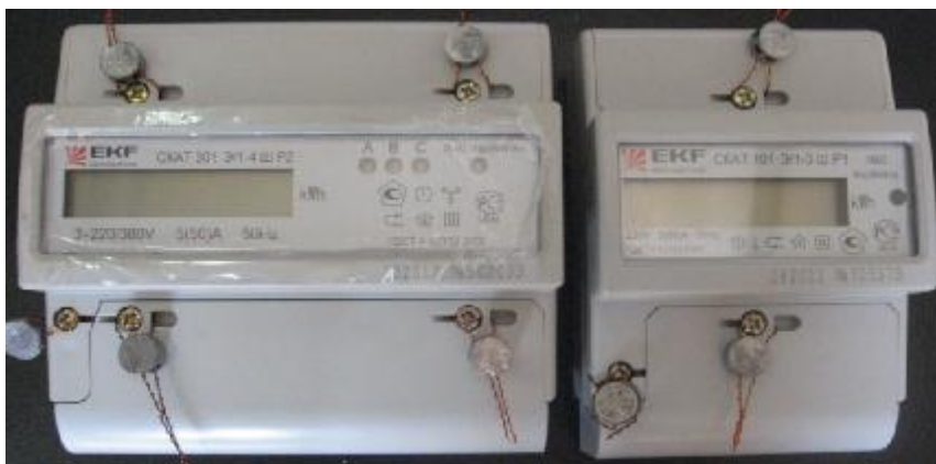
Рисунок 3. Места установки пломб
