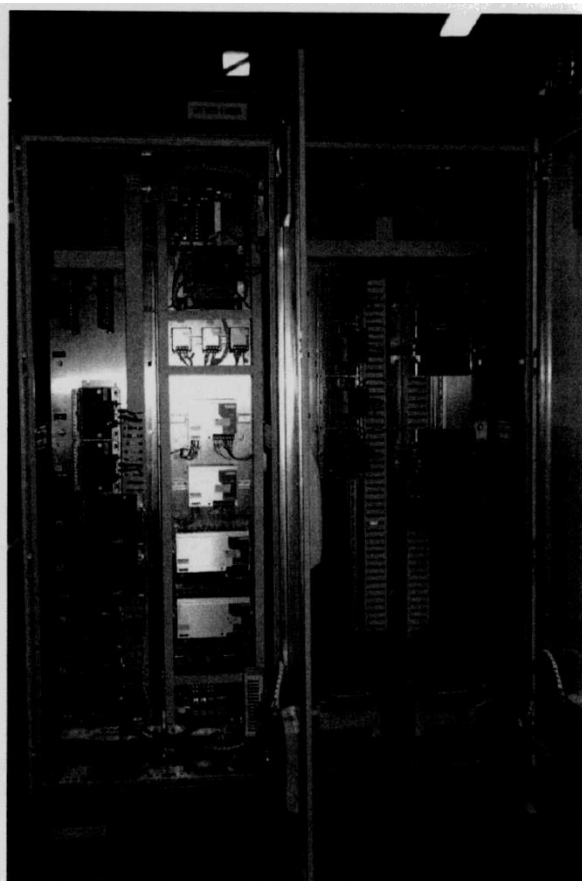
Рисунок 2 — Внешний вид приборного шкафа
