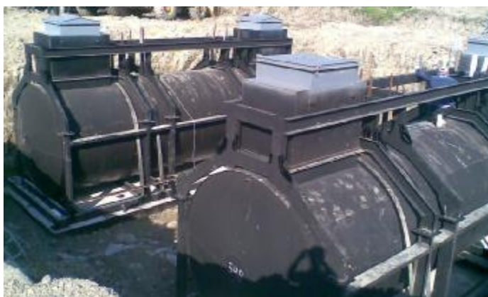
Рисунок 1-2 Общий вид резервуаров.
