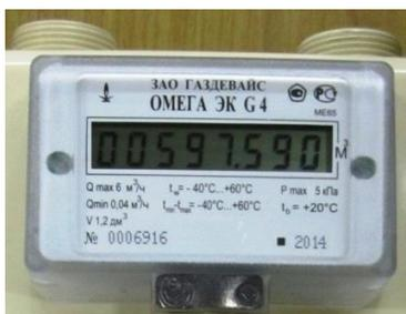
Рисунок 5 - Табличка счетчика газа ОМЕГА ЭК
