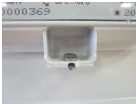
Рисунок 2 – Место пломбирования счетчика газа ГАММА G6
