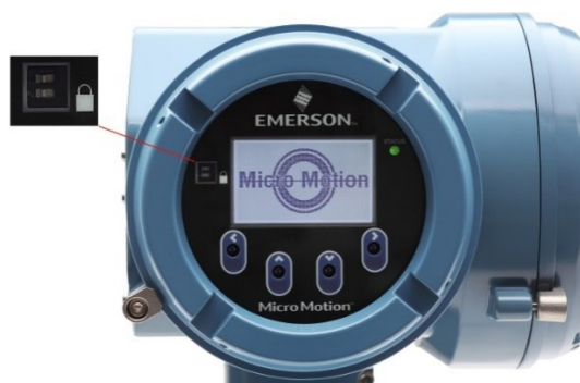
Рисунок 12. Переключатель защиты от записи электронного преобразователя модели 5700.
