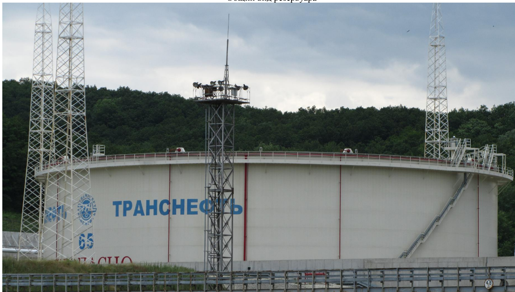
Общий вид резервуара
